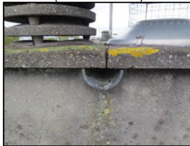
Photo N° 137 AMIANTE CIMENT -- Toiture Conduits de fluide Chute E.P.(Fibres-ciment)
