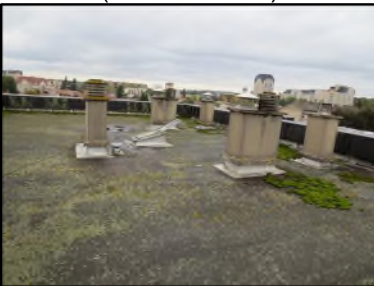
Photo N° 141 ECH-N°3 AMIANTE CIMENT --Toiture Planchers Bitume noir
