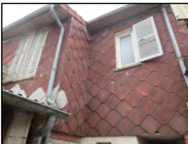
Photo N° 629 ECH-N°2 AMIANTE CIMENT --FACADE CÔTE COUR Murs Bardage (Fibres-ciment)
