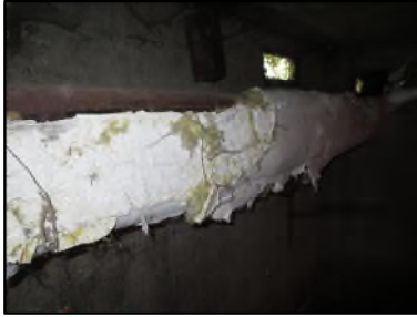
Photo N° 674 ECH-N°1 CALORIFUGEAGE --COULOIR DE CAVE Conduits de fluide Laine minérale + enveloppe plâtrée
