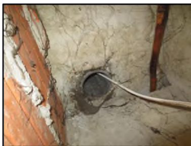
Photo N° 675 AMIANTE CIMENT -- GAINTE TECHNIQUE - 4 Conduits de fluide Ventilation haute (Fibres- ciment)
