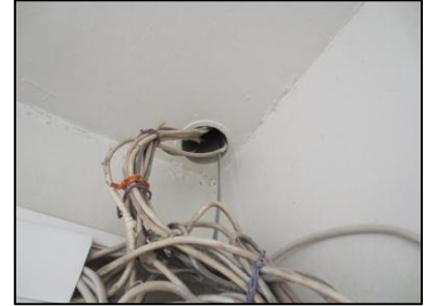
Photo N° 964 AMIANTE CIMENT -- PALIERS RDC à +3 Plafonds Fourreau
