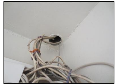
Photo N° 964 AMIANTE CIMENT -- PALIERS RDC à +3 Plafonds Fourreau
