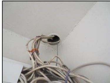
Photo N° 964 AMIANTE CIMENT -- PALIERS RDC à +3 Plafonds Fourreau
