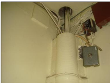
Photo N° 5933 AMIANTE CIMENT - -PALIERS +1 à +4 Gains & coffres verticaux Fourreau
