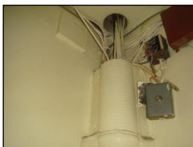
Photo N° 5933 AMIANTE CIMENT - -PALIERS +1 à +4 Gains & coffres verticaux Fourreau
