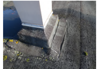
Photo N° 354 -- Toiture Goudron noir/Bitume d'étanchéité
