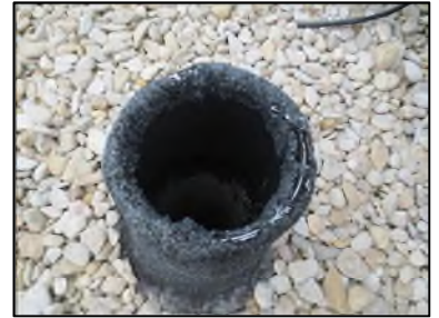
Photo N° 346 AMIANTE CIMENT -- Toiture Ventilation haute (Fibres- ciment)
