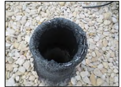
Photo N° 346 AMIANTE CIMENT -- TOITURE Toiture Ventilation haute (Fibres-ciment)
