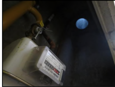
Photo N° 344 AMIANTE CIMENT -- GAINTE TECHNIQUE 4 Gaines & coffres horizontaux Ventilation haute (Fibres-ciment)
