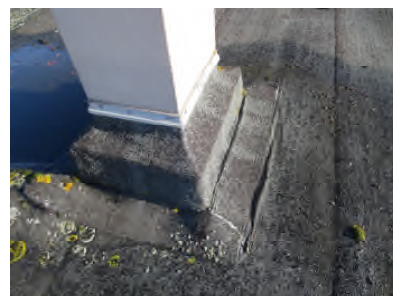
Photo N° 354 -- Toiture Goudron noir/Bitume d'étanchéité
