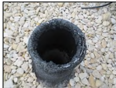
Photo N° 346 AMIANTE CIMENT -- Toiture Ventilation haute (Fibres- ciment)
