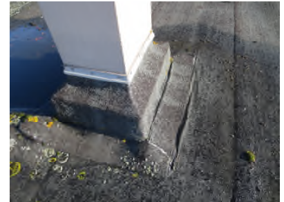
Photo N° 354 --TOITURE Toiture Goudron noir
