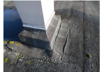
Photo N° 354 --TOITURE Toiture Goudron noir
