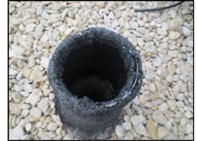
Photo N° 346 AMIANTE CIMENT -- TOITURE Toiture Ventilation haute (Fibres-ciment)
