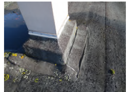
Photo N° 354 -- Toiture Goudron noir/Bitume d'étanchéité
