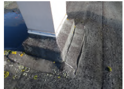
Photo N° 354 --TOITURE Toiture Goudron noir
