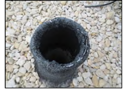
Photo N° 346 AMIANTE CIMENT -- TOITURE Toiture Ventilation haute (Fibres-ciment)
