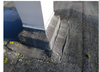
Photo N° 354 --TOITURE Toiture Goudron noir
