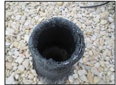
Photo N° 346 AMIANTE CIMENT -- TOITURE Toiture Ventilation haute (Fibres-ciment)
