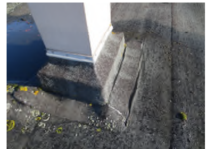
Photo N° 354 -- Toiture Goudron noir/Bitume d'étanchéité
