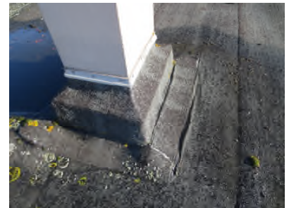
Photo N° 354 --TOITURE Toiture Goudron noir
