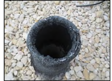
Photo N° 346 AMIANTE CIMENT -- TOITURE Toiture Ventilation haute (Fibres-ciment)
