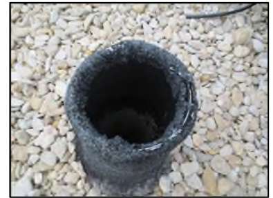
Photo N° 346 AMIANTE CIMENT -- TOITURE Toiture Ventilation haute (Fibres-ciment)
