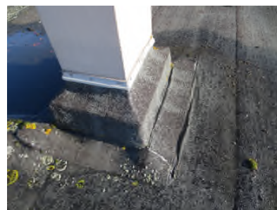
Photo N° 354 -- Toiture Goudron noir/Bitume d'étanchéité
