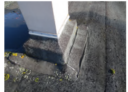
Photo N° 354 --TOITURE Toiture Goudron noir
