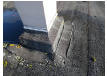
Photo N° 354 -- Toiture Goudron noir/Bitume d'étanchéité
