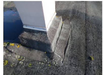
Photo N° 354 --TOITURE Toiture Goudron noir
