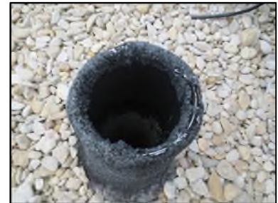
Photo N° 346 AMIANTE CIMENT -- TOITURE Toiture Ventilation haute (Fibres-ciment)
