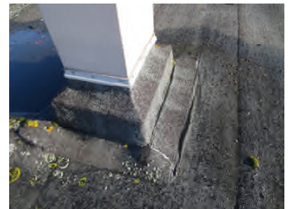
Photo N° 354 -- Toiture Goudron noir/Bitume d'étanchéité
