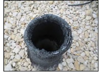
Photo N° 346 AMIANTE CIMENT -- TOITURE Toiture Ventilation haute (Fibres-ciment)
