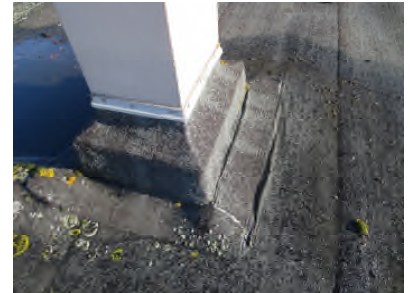
Photo N° 354 --TOITURE Toiture Goudron noir
