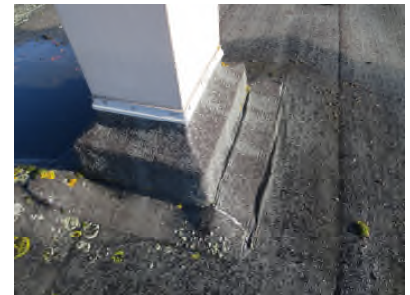
Photo N° 354 --TOITURE Toiture Goudron noir
