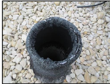
Photo N° 346 AMIANTE CIMENT Toiture terrasse Ventilation Ventilation haute (Fibres-ciment)
