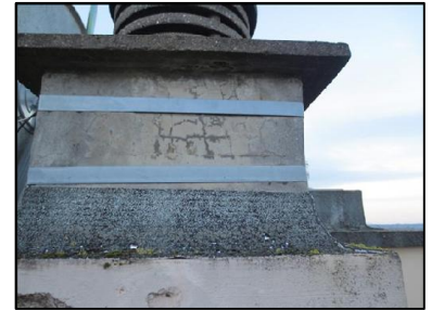
Photo N° 373 ECH-N°4 --Toiture terrasse Toiture Revêtement goudronné Bitume noir
