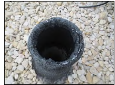
Photo N° 346 AMIANTE CIMENT -- TOITURE Toiture Ventilation haute (Fibres-ciment)
