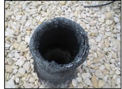
Photo N° 346 AMIANTE CIMENT -- TOITURE Toiture Ventilation haute (Fibres-ciment)
