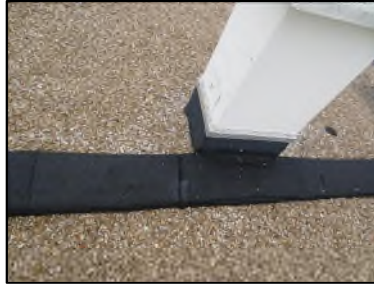
Photo N° 416 ECH-N°1 Toiture Murs Revêtement goudronné d'étanchéité
