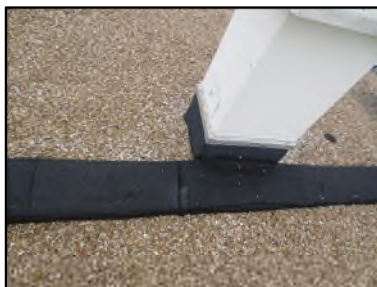
Photo N° 416 ECH-N°1 Toiture Murs Revêtement goudronné d'étanchéité
