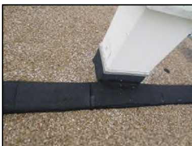
Photo N° 416 ECH-N°1 Toiture Murs Revêtement goudronné d'étanchéité
