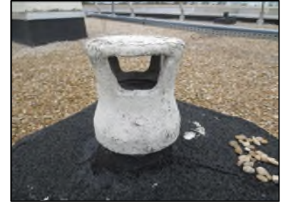
Photo N° 420 AMIANTE CIMENT -- Toiture Gaines & coffres verticaux Ventilation haute (Fibres-ciment)
