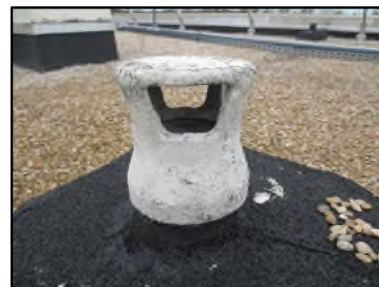
Photo N° 420 AMIANTE CIMENT -- Toiture Gains & coffres verticaux Ventilation haute (Fibres-ciment)
