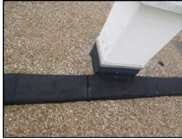
Photo N° 416 ECH-N°1 Toiture Murs Revêtement goudronné d'étanchéité
