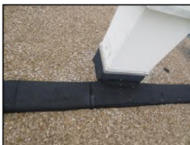
Photo N° 416 ECH-N°1 Toiture Murs Revêtement goudronné d'étanchéité
