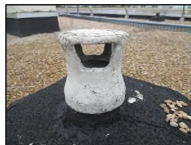
Photo N° 420 AMIANTE CIMENT -- Toiture Gains & coffres verticaux Ventilation haute (Fibres-ciment)
