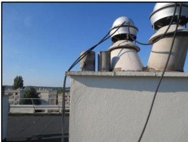
Photo N° 968 AMIANTE CIMENT -- TOITURE Conduits de fumée Cheminée (Fibres-ciment)
