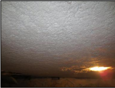
Photo N° 966 ECH-N°1 FLOCCAGE -- LOCAL COMMUN -1 Plafonds floccage
