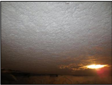
Photo N° 966 ECH-N°1 FLOCCAGE - -LOCAL COMMUN -1 Plafonds flocage
