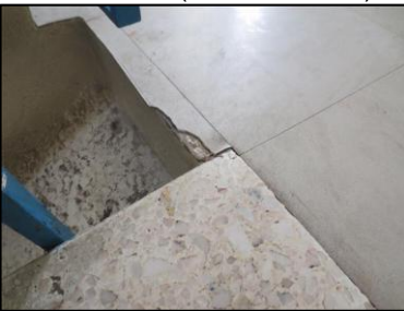
Photo N° 979 ECH-N°1 REVETEMENT DE SOL --PALIERS +1 Planchers Dalles de sol 30x30
