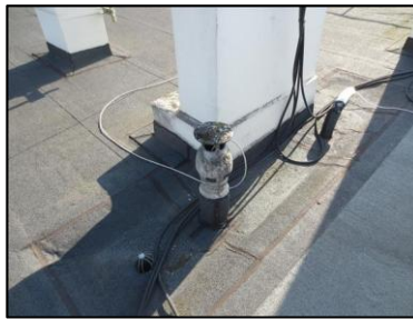
Photo N° 969 AMIANTE CIMENT -- TOITURE Toiture Chapeau (Fibres- ciment) x2
