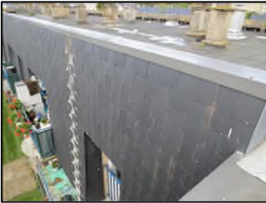
Photo N° 100 ECH-N°4 Toiture Terrasse Façade terrasse Ardoise noir
