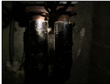
Photo N° 107 ECH-N°3 CALORIFUGEAGE --Sous Sol Conduits de fluide Liège + plâtre
