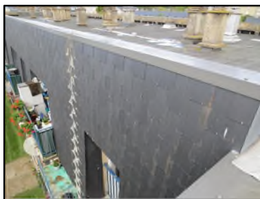
Photo N° 100 ECH-N°4 Toiture Terrasse Façade terrasse Ardoise noir
