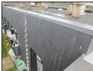
Photo N° 100 ECH-N°4 Toiture Terrasse Façade terrasse Ardoise noir
