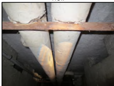
Photo N° 106 ECH-N°2 CALORIFUGEAGE --Sous Sol Conduits de fluide Laine minérale + enveloppe plâtrée
